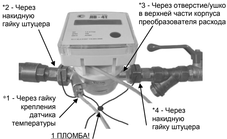
Рис.4 – Пломбирование после монтажа на трубопроводе
